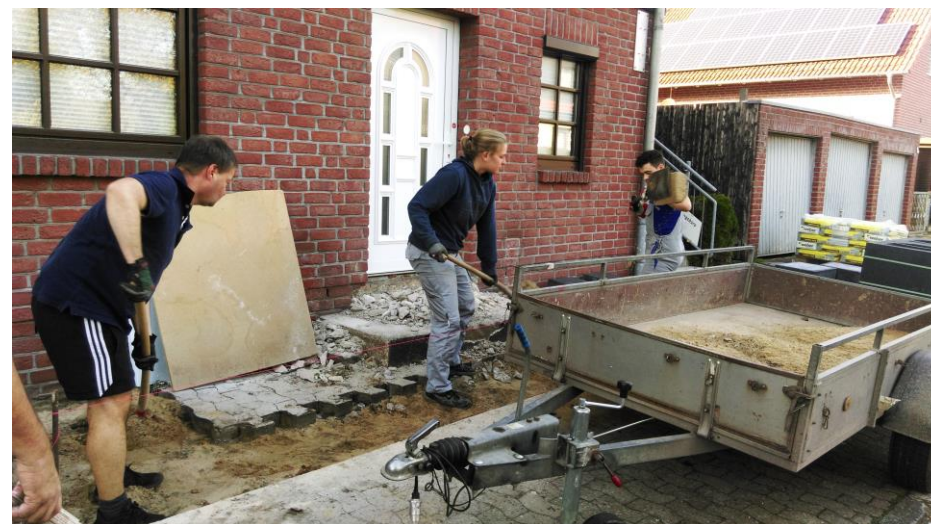
Bau der Rollstuhlrampe
