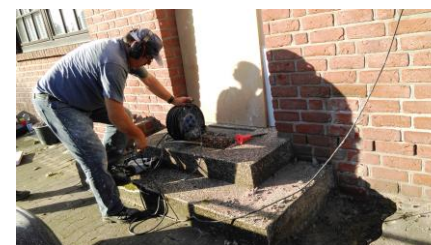
Bau der Rollstuhlrampe
